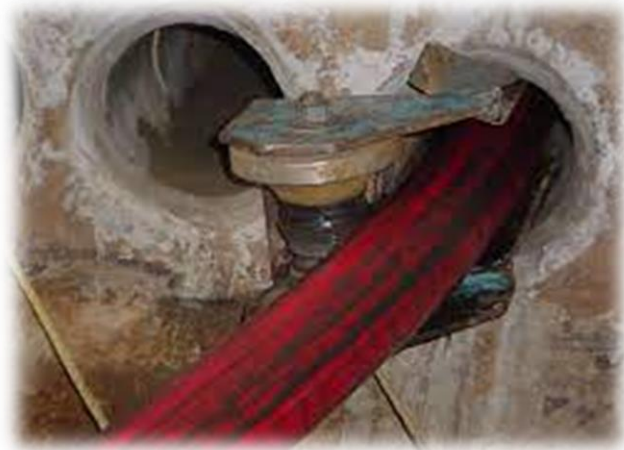
Tendido de Línea eléctrica de media tensión en ductos
