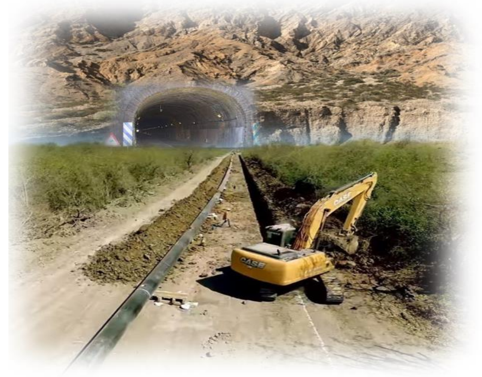
Tendido de tubería de gas de 4" para Zonda y Ullúm
